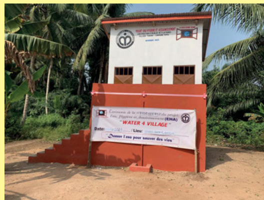
Bild oben: Ein Latrinenblock mit 3 Toiletten
