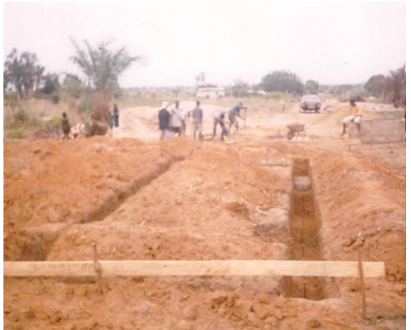
▲ Ein Bild aus der Bauzeit
