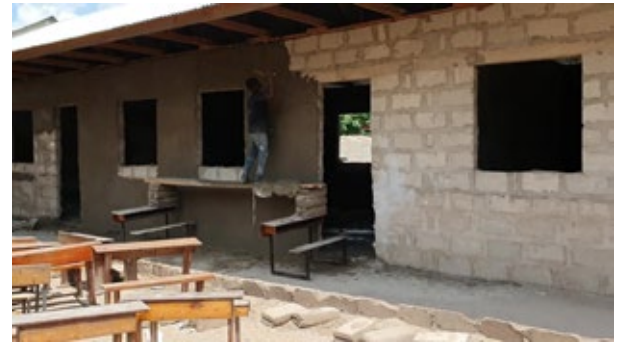
▲ Die Arbeiten schreiten gut voran.
